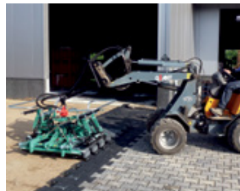
Układanie za pomocą ładowarki to świetna alternatywa
