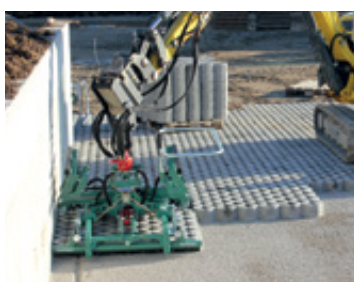
Układanie przy ścianie ... to prosta sprawa
